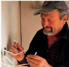
электрик elektrik electrician
